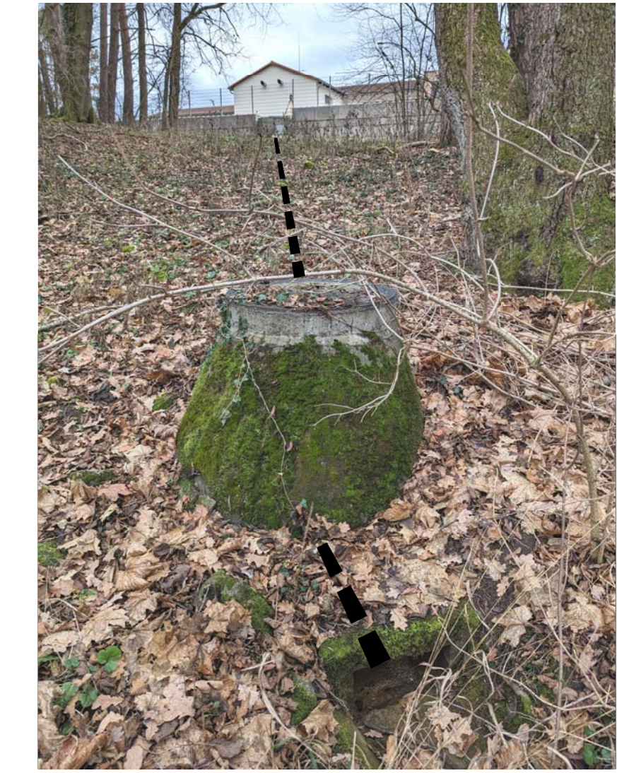
Einleitungsstelle über Betonrinne (Flurnummer 543)
